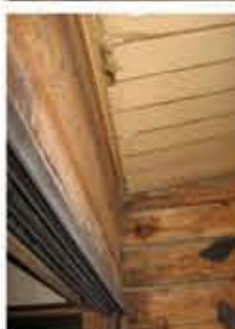
天井 浴槽周り
