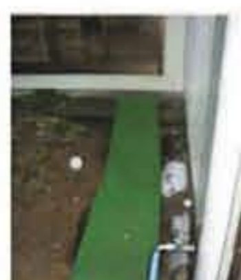
土台修正後の養生板
