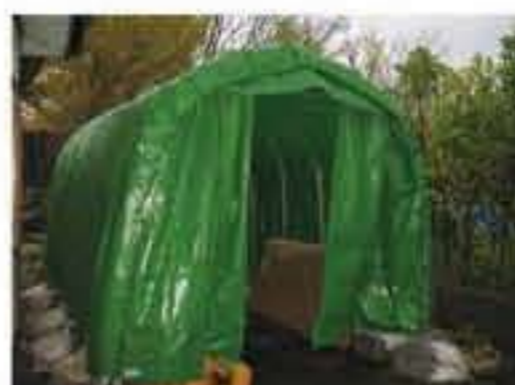
資材置き場としてビニールハウスを仮設置
